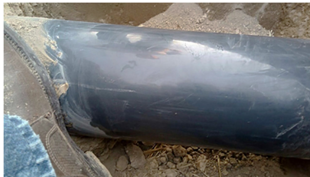
شکل ۶- لوله PVC حفاری شده پس از ۲۸ سال کاربرد در دشت مغان [۲۹].
