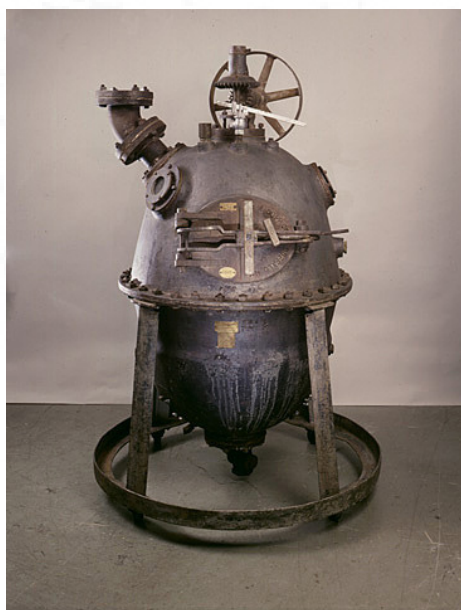
شکل ۲- باکلایزر یا ظرف تولید باکلیت.
